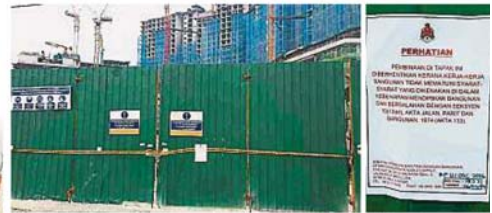
甲洞大都会公园附近一处涉及建筑废料掉落事故的高楼工地, 已接获吉隆坡市政局发出的停工令。
